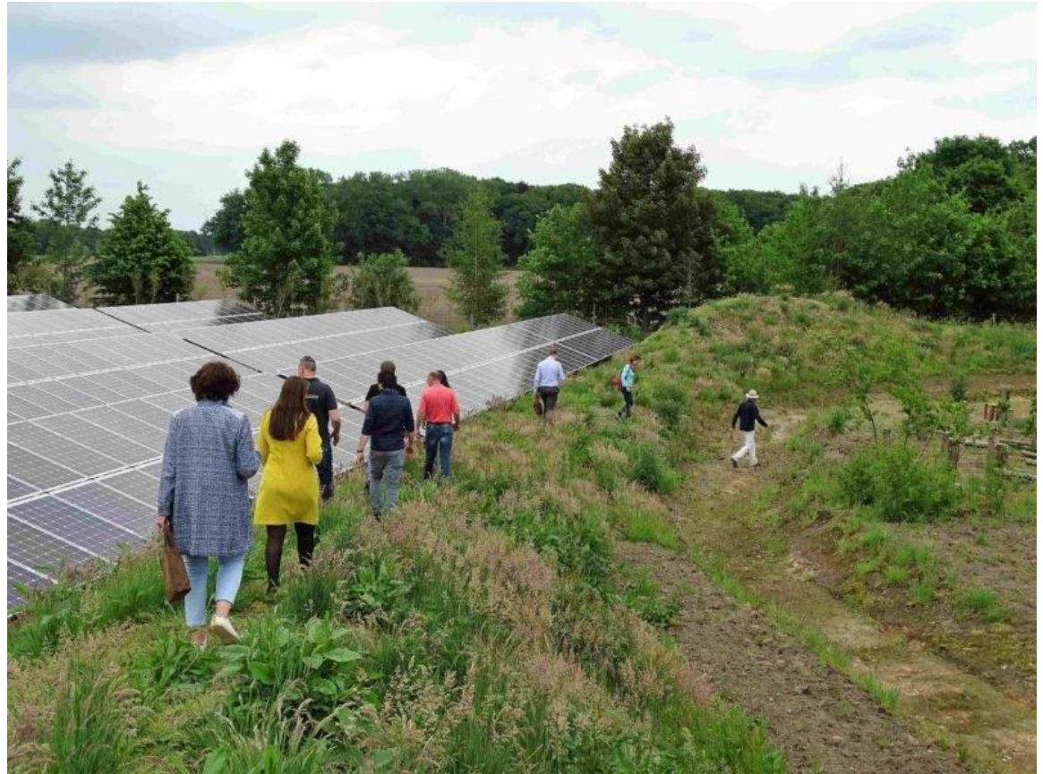
Solar park de Kwekerij Hengelo
